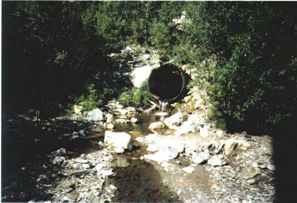
UMA Photo 15-15A Eagle Creek Culvert
