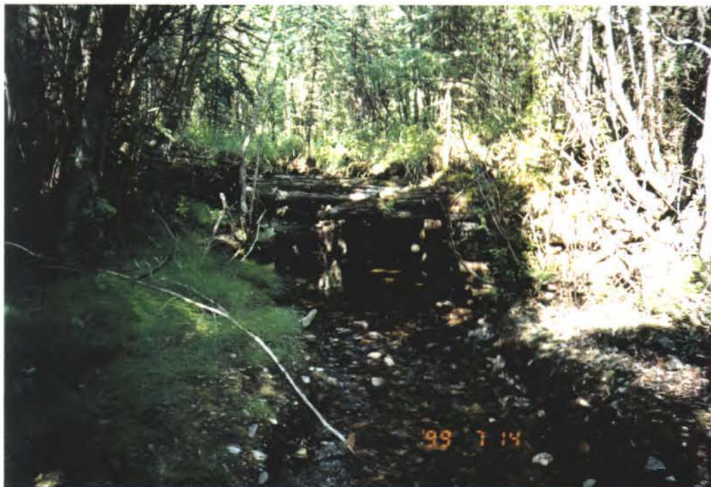
UMA Photo 15-16A Eagle Creek Timber Bridge
