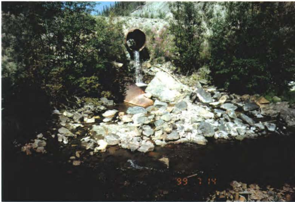
UMA Photo 15-10A Wolverine Creek Outlet Culvert
