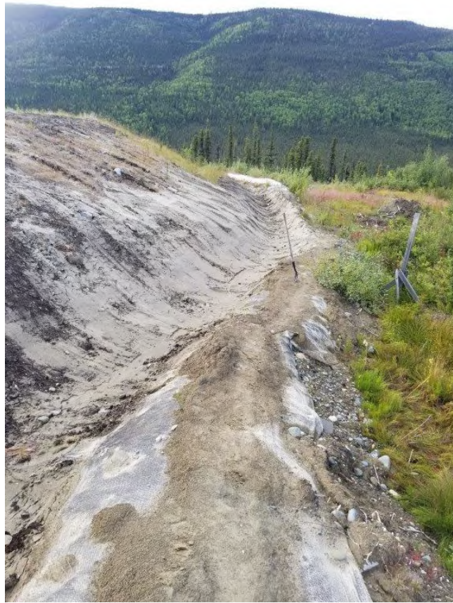
Photo 10 - DSTF Diversion Ditch (August 18/20)
